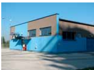
EC Skawina: Instalacja sterowania mazutownią
